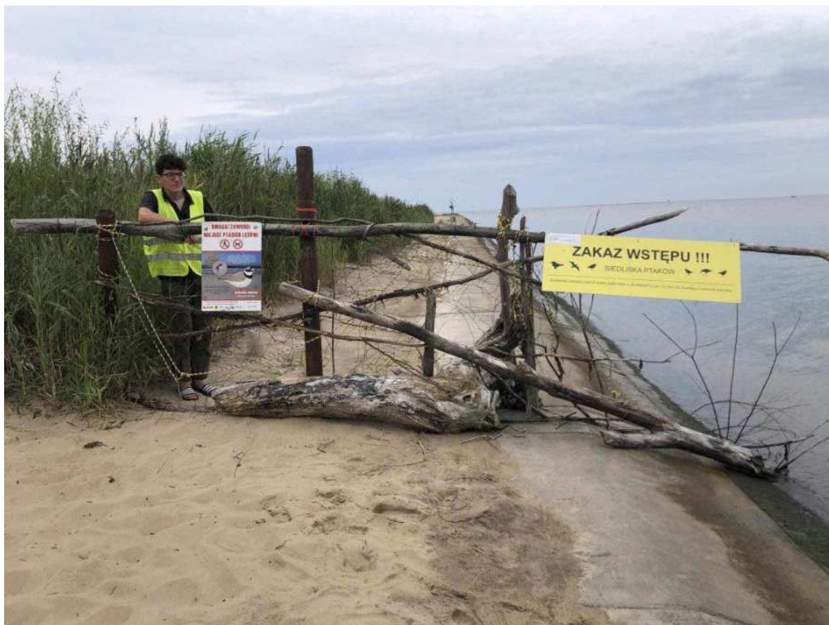
Fot. 3. Strażnik przy ogrodzeniu na kierownicy zachodniej Wisły
